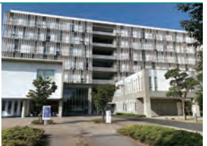
大気海洋研究棟
