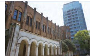
医学部本館と教育研究棟
